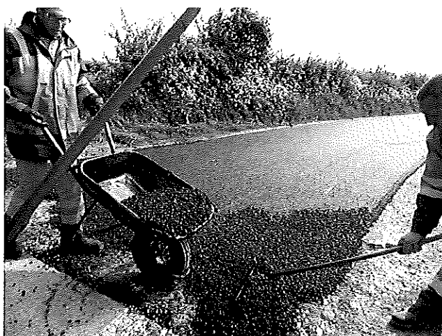
Goudronnage Rue du Royaume
