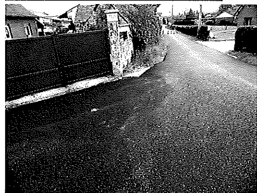
Travaux de voirie en mai
