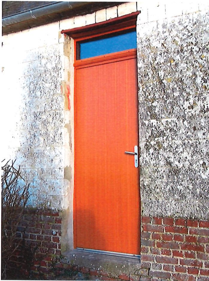
En décembre : Remplacement de la porte de la sacristie , devenue trop vétuste elle menaçait de tomber (travaux effectués par l'Entreprise Lefrançois)
