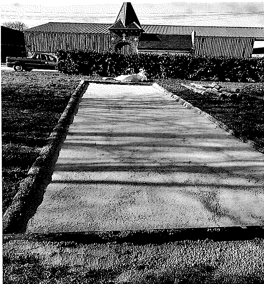
Remise en état du terrain de pétanque à Harlettes
