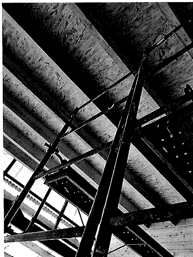
Travaux dans le préau de l'école
