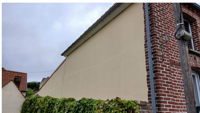
Le pignon, également, a été repeint
