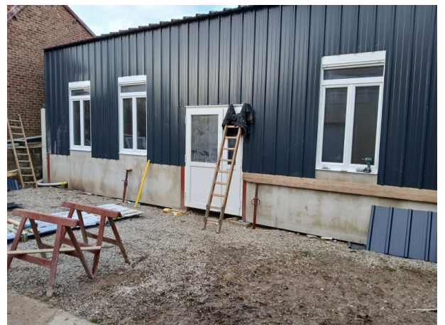
Début de construction du local technique, dans la cour de la mairie
