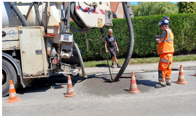
Aspiration des tuyaux (pour éviter les débordements en cas de grosses pluies)
