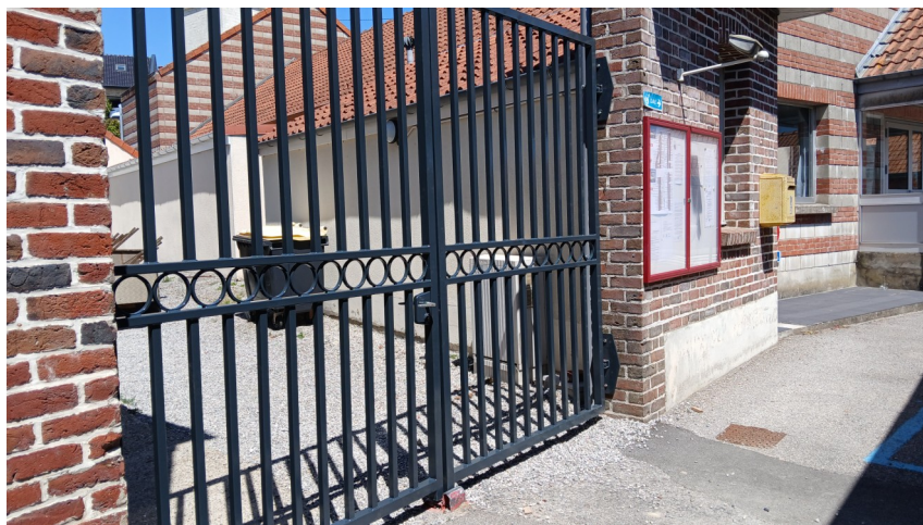
Rénovation du portail de la mairie
