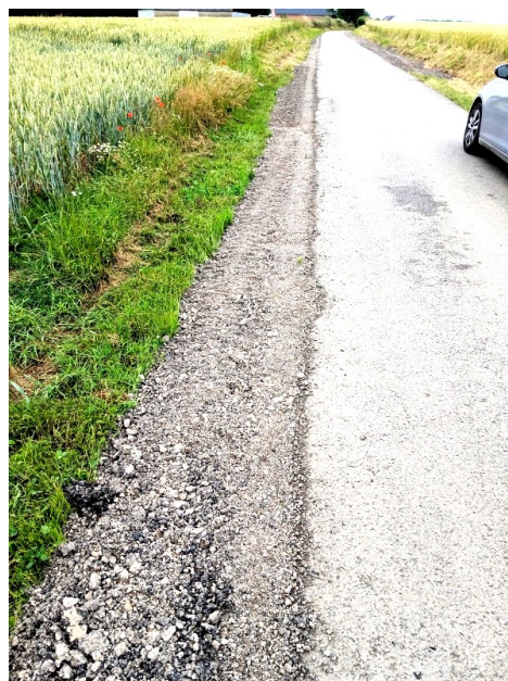
Renforcement accotements Rue du Royaume
