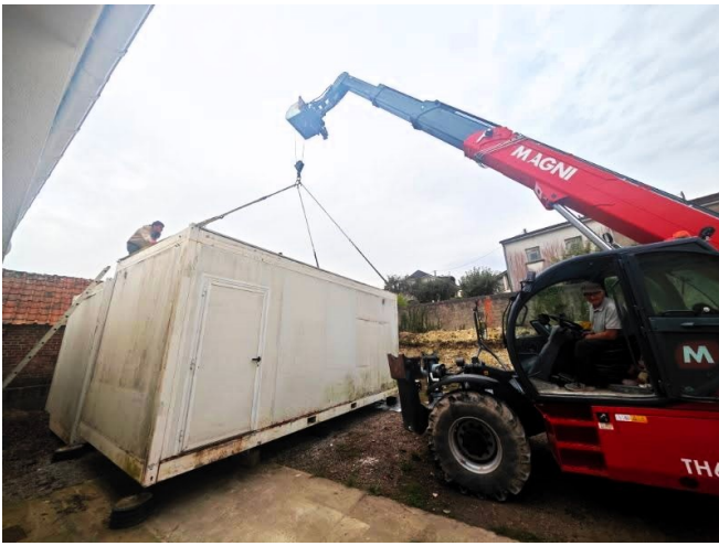
Enlèvement du modulaire dans la cour de la mairie, avant l'implantation du local technique
