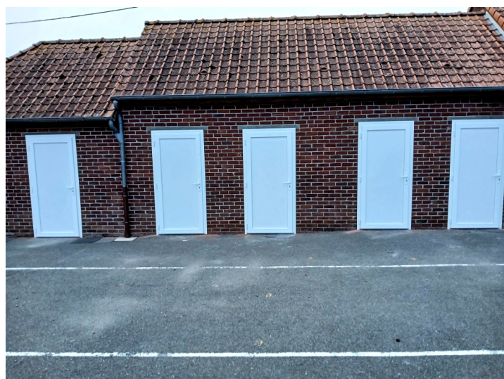
Remplacement des portes des toilettes à l'école par des menuiseries en pvc
